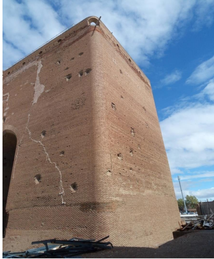
Foto. 15: Tebriz Alishah Mescidi Güney ve Doğu Duvarı
